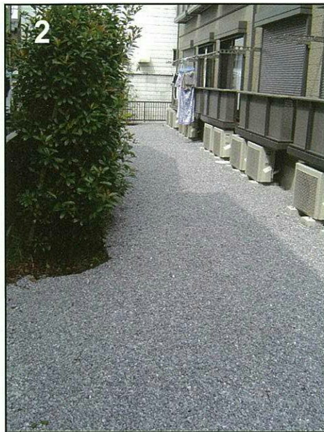
2 砂利(5号碎石)敷き詰め完了
